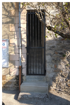
nouvelle porte nouvelle marche
